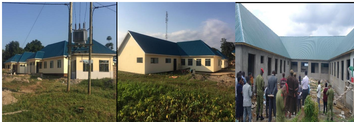
Picha Na.1: Baadhi ya majengo mapya ya Kituo cha Afya Masukulu na ukarabati- Makandana Hospital
